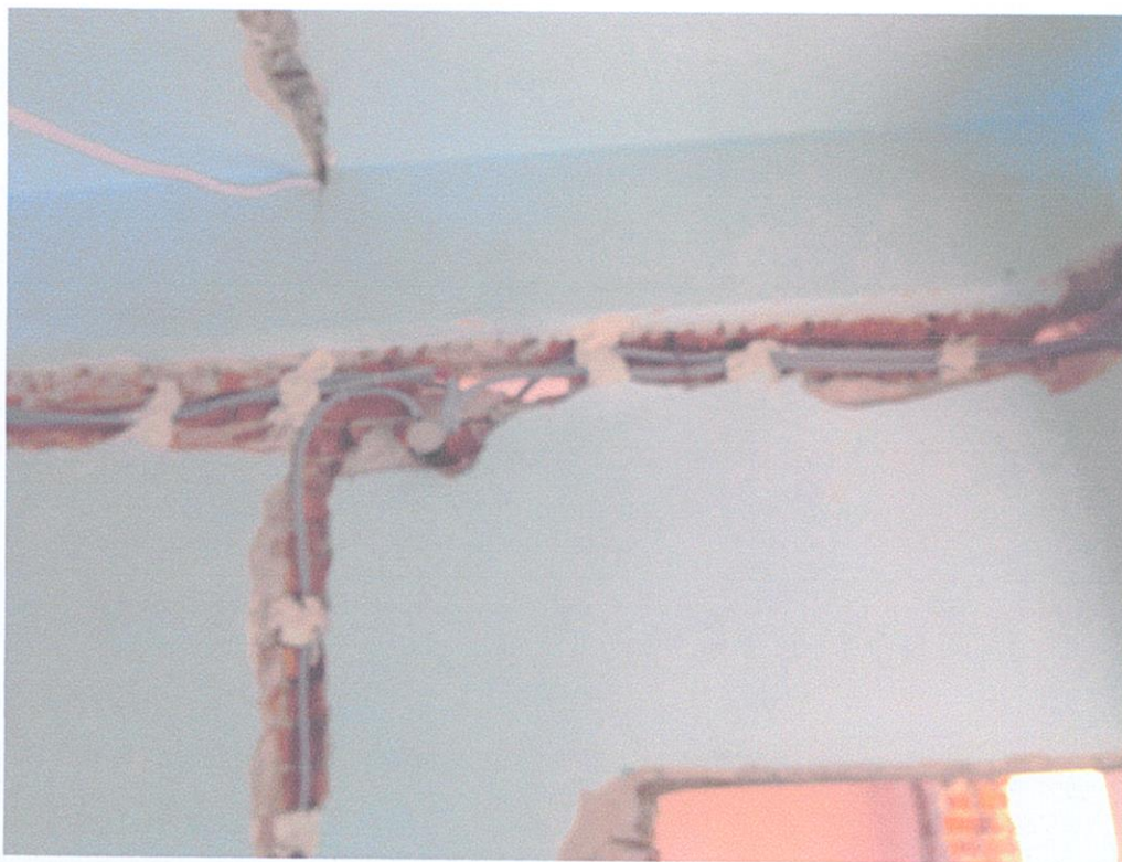
22. Напречно прерязване и дори пробиване на носещи плътни тухлени зидове.
