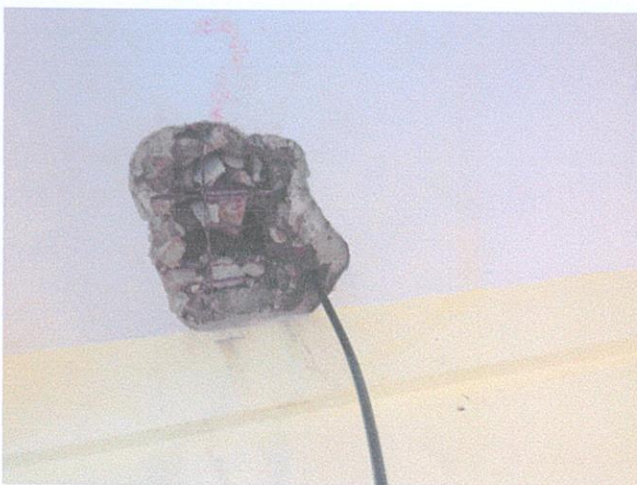
5. Отвори в плоча и нарушена структура на бетона
