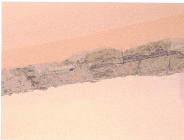
3. Греди са разрушено бетонно покритие
