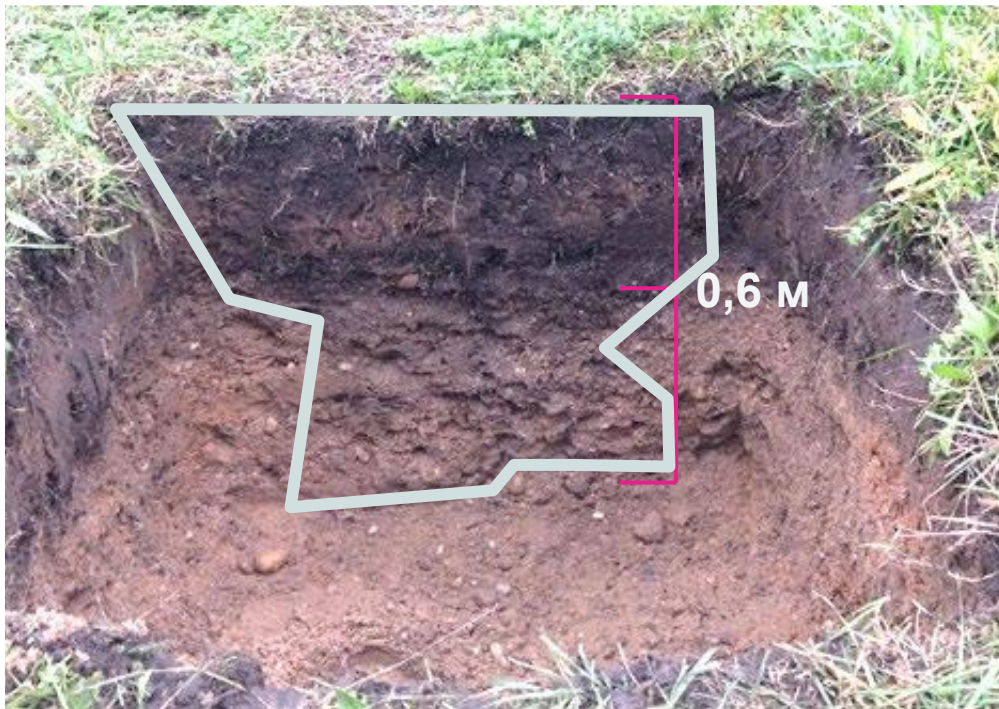
Видима промяна в дълбочината, Близко до входа — на разстояние 4 м
