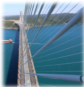
Мост Sanakkale, Турция
