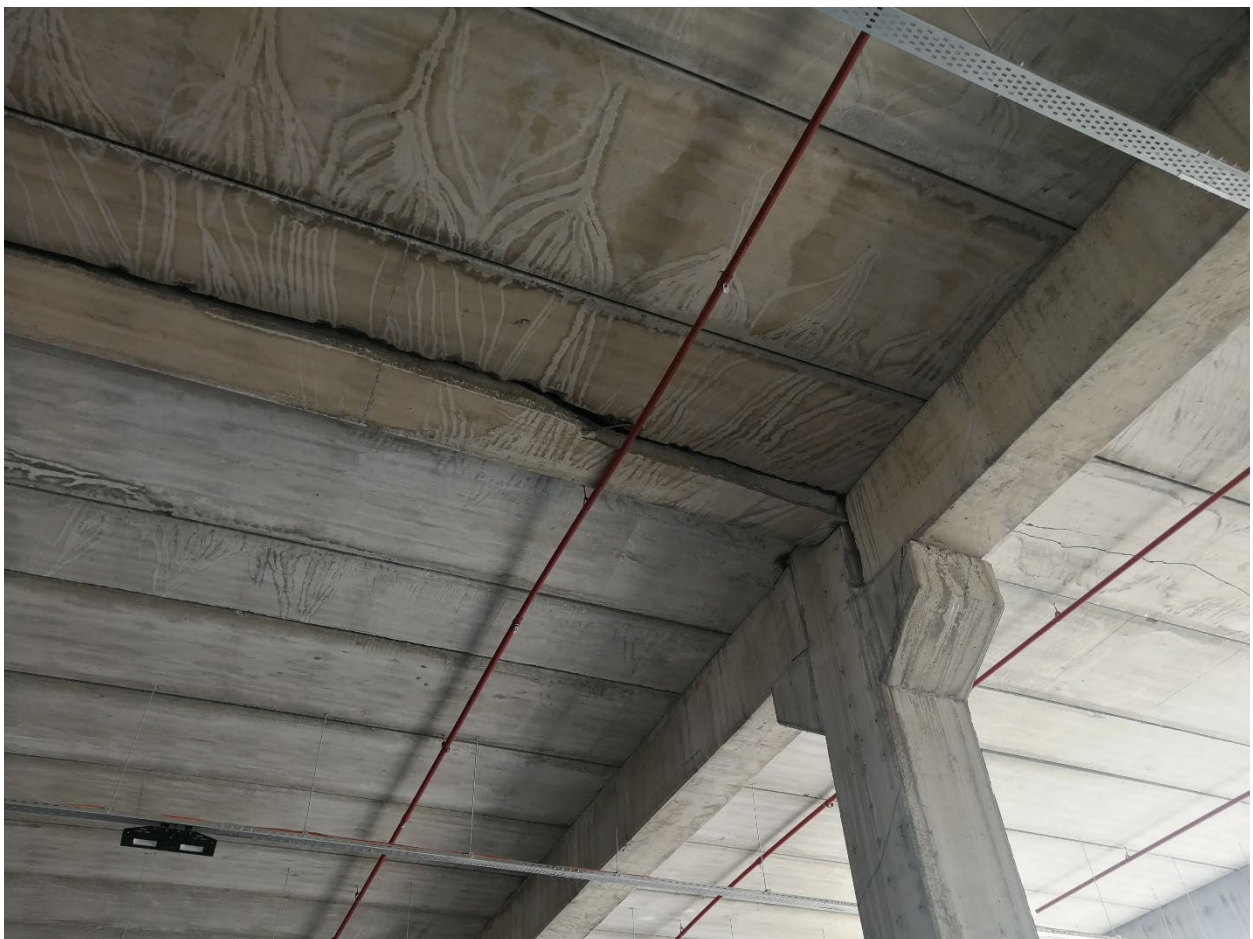
315 – надлъжна пукнатина в погов панел тип „Спирол“, който явно няма напречна армировка
