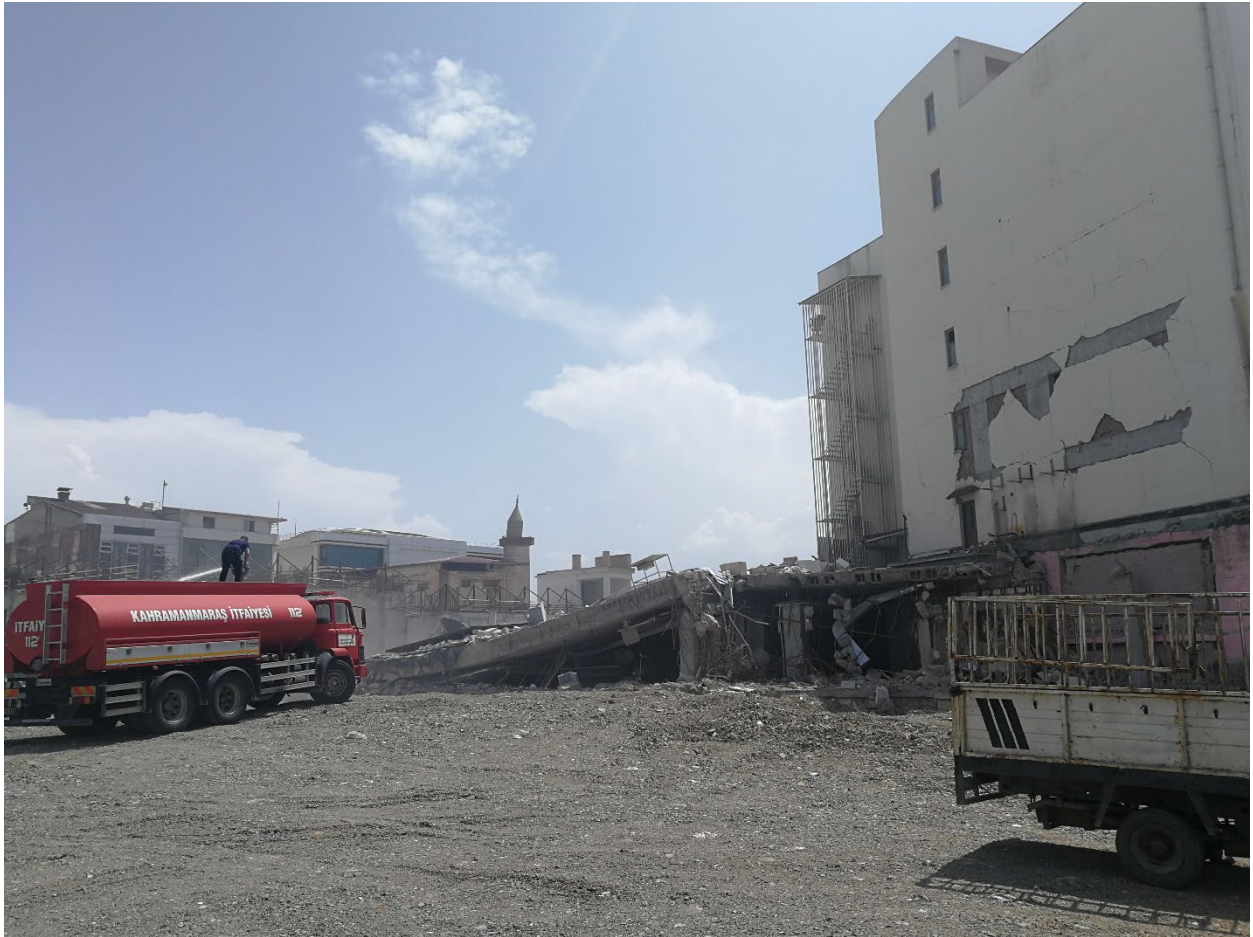
328 – поливане с вода по време на разчистване на разрушения
