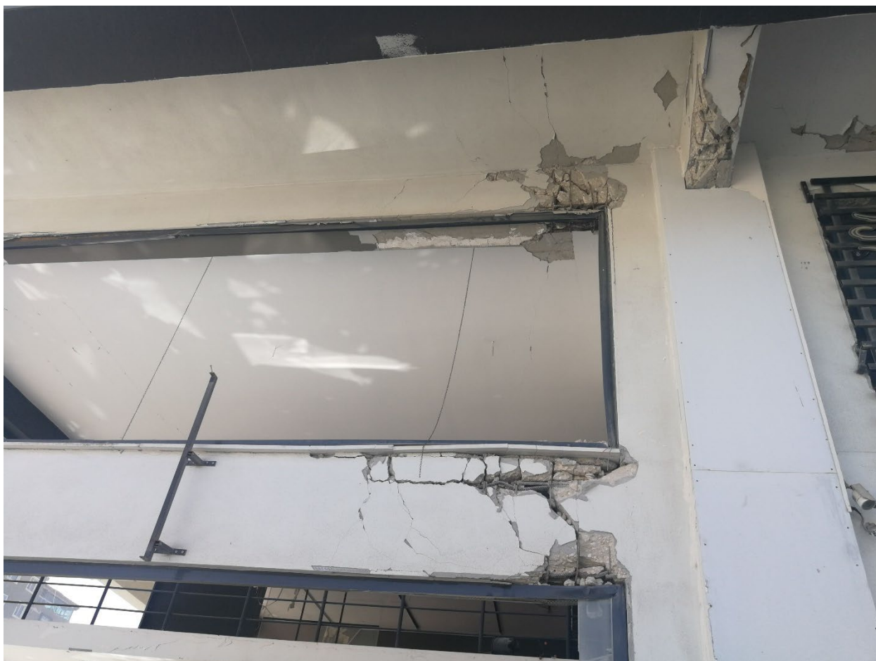
221 – същата сграда, концепцията „силни колони – слаби греди“ в действие в първите два етажа
