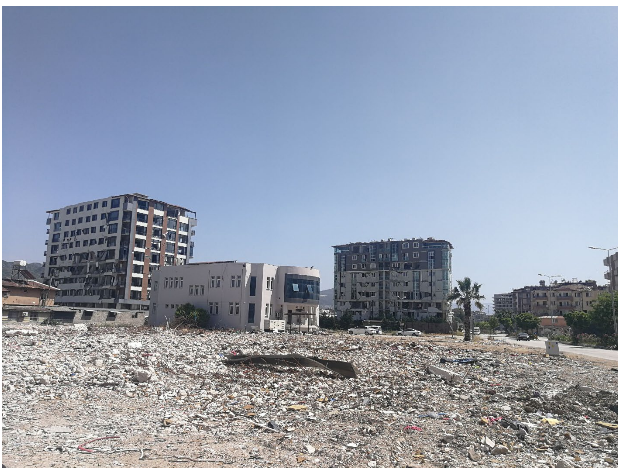
214 – зона на разчистени разрушения, дава идея за мащаба на последствията
