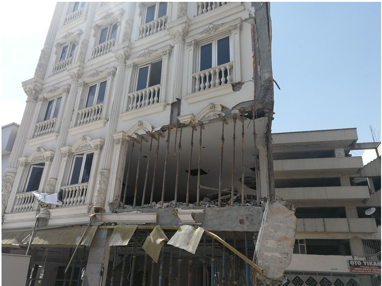
342 – подпряна пострадала сграда със ст. б. конструкция с буталфорна „стара“ фасада
