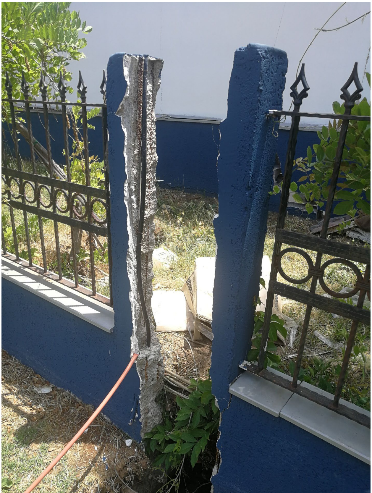
169 – разцепване на ограда поради преместване на бреговата ивица към морето
