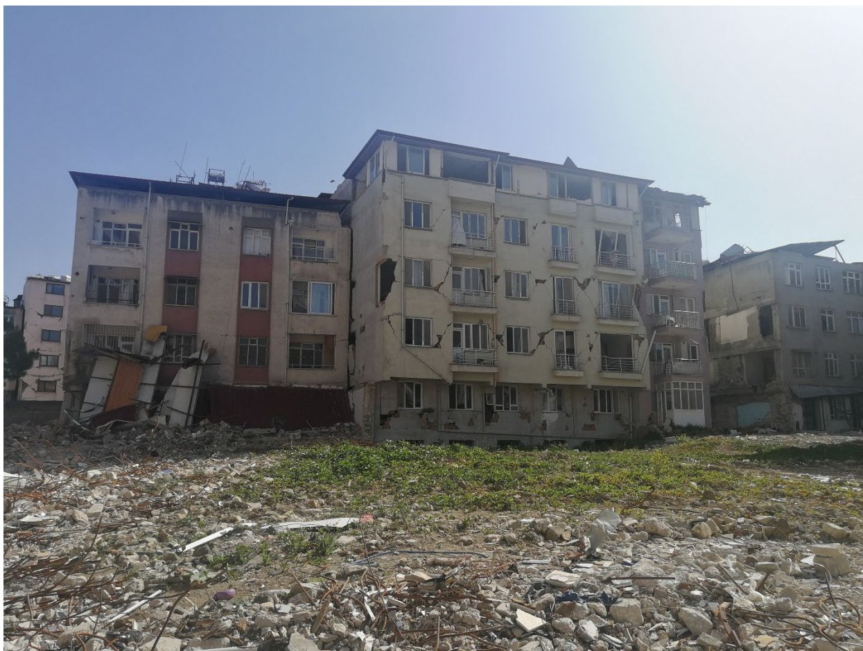
247 – Вляво жилищна сграда от 1980-1990 с нерегулярна фасада и X-образни разрушения на зидария от тухли 4-ки, вдясно подобна с регулярна фасада без разрушения
