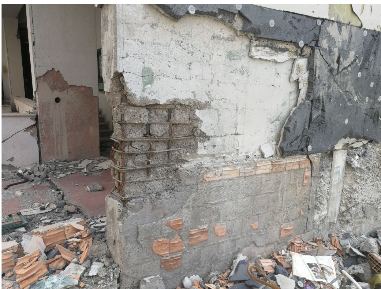
153 – изкълчване на носещи железа в шайби
