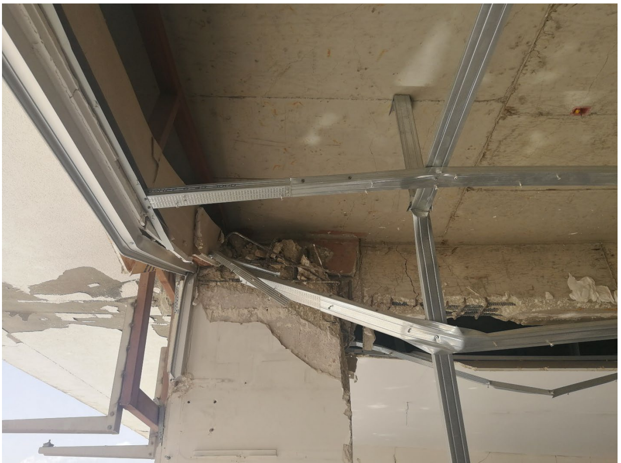
203 – липса на адекватен рамков възел, колоната и гредата не съвпадат хоризонтално
