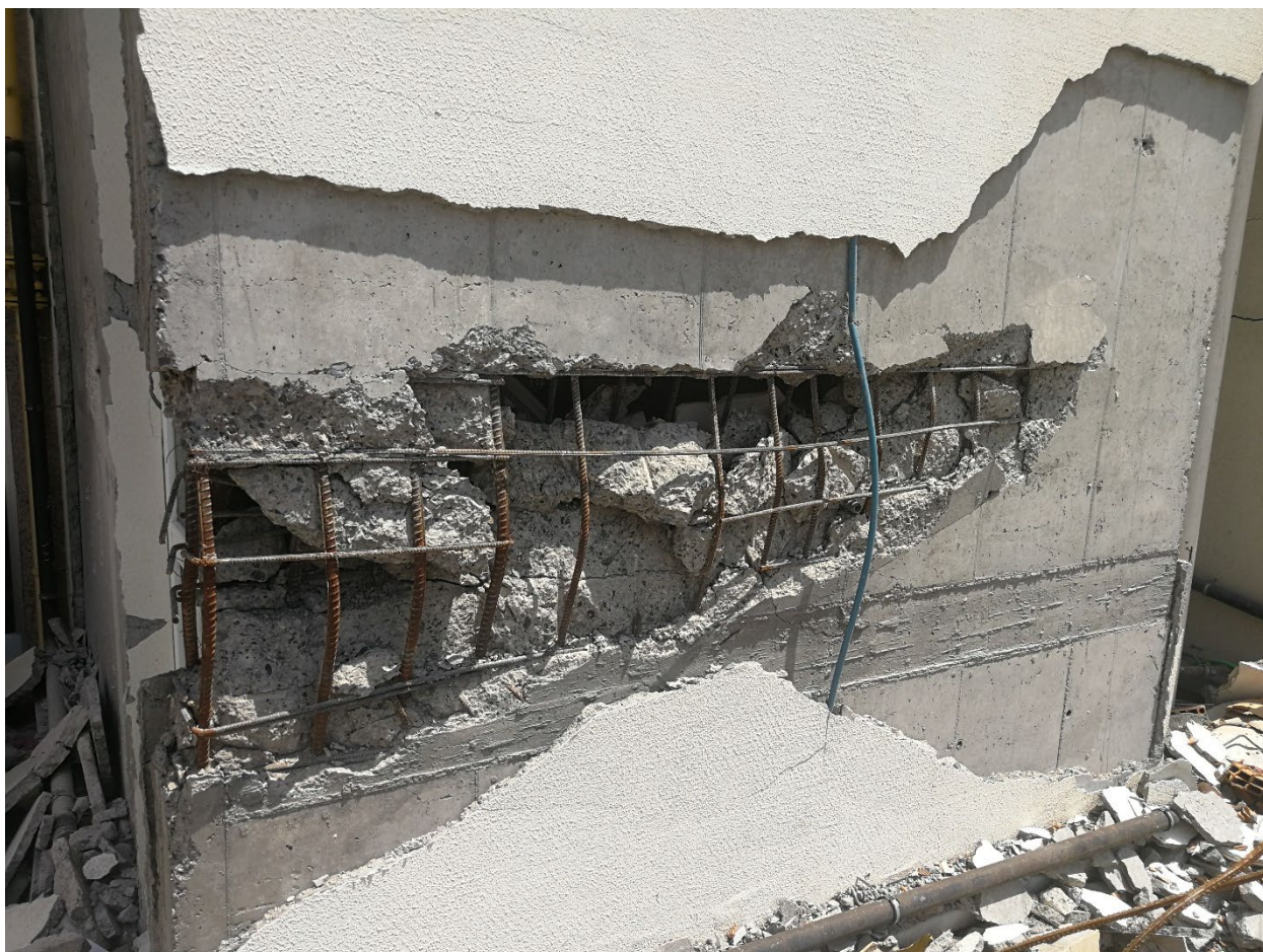
151 – изкълчване на носещи железа в шайби
