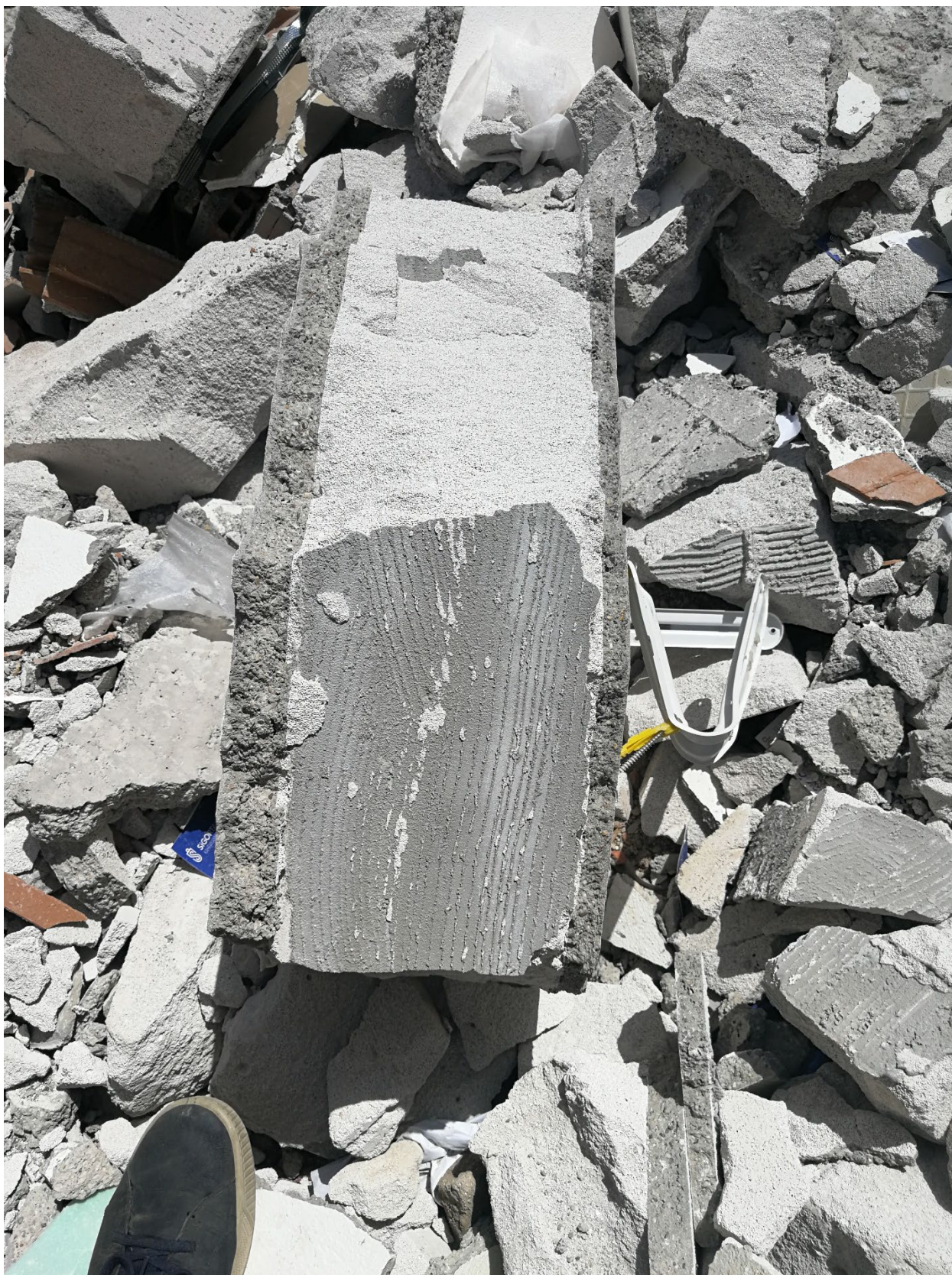
304 – парче от разрушен фасаден елемент, състоящ се от външна вар циментова мазилка, газобетон, вътрешна вар циментова мазилка
