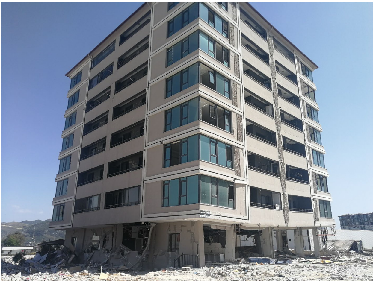
199 – пострадала нова сграда с недостатъчна носимоспособност на колоните и шайбите на партера
