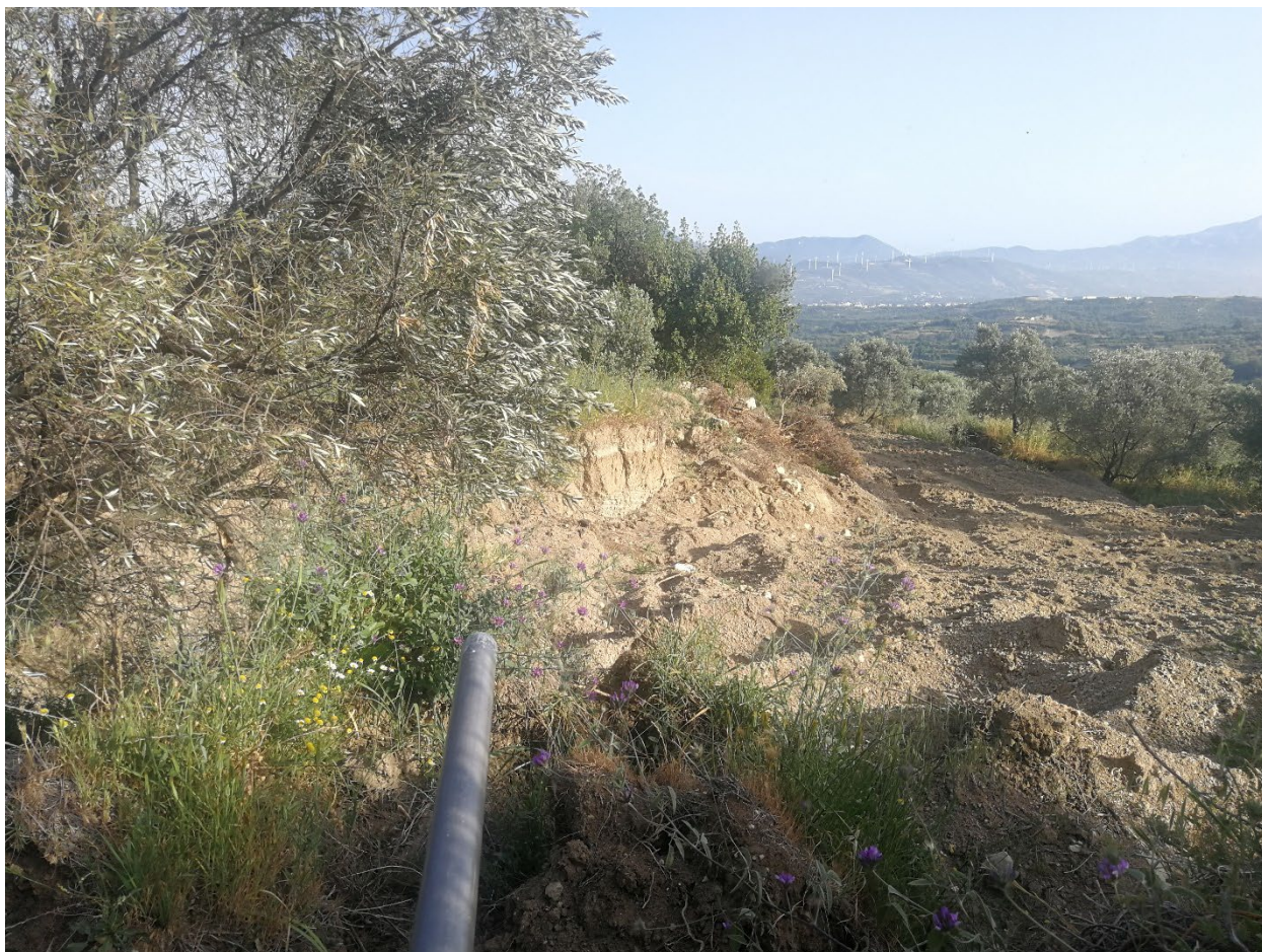
270 – прекъснатата тръба от импровизиран водопровод, обратен поглед
