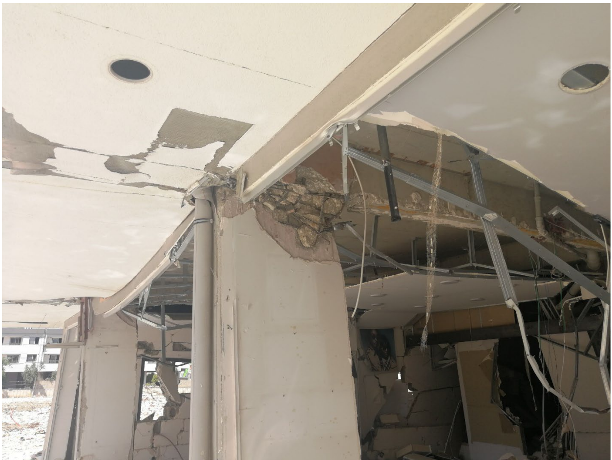
206 – гредата е по-корава от колоната и колоната е започнала да се разрушава първа
