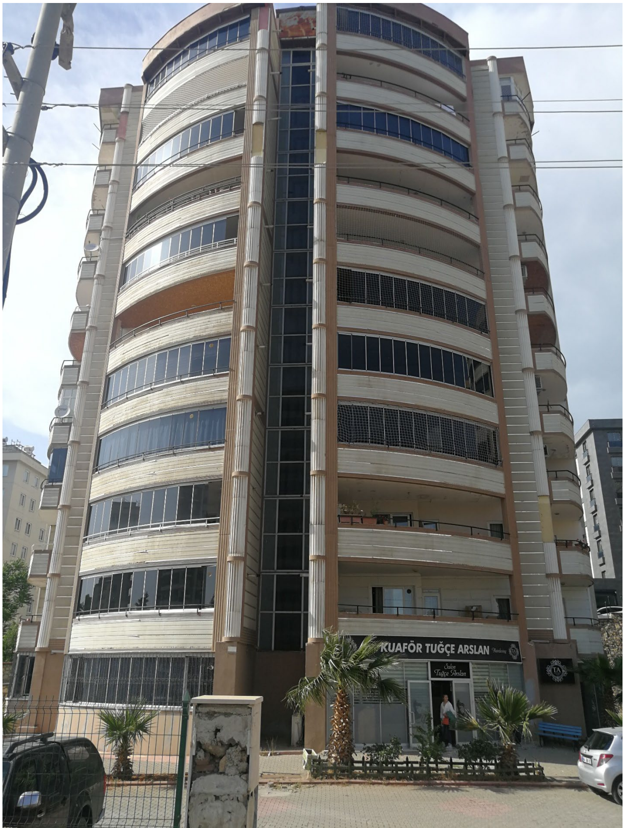
404 – жилищна сграда със стоманена конструкция с вертикални връзки без никакви повреди
