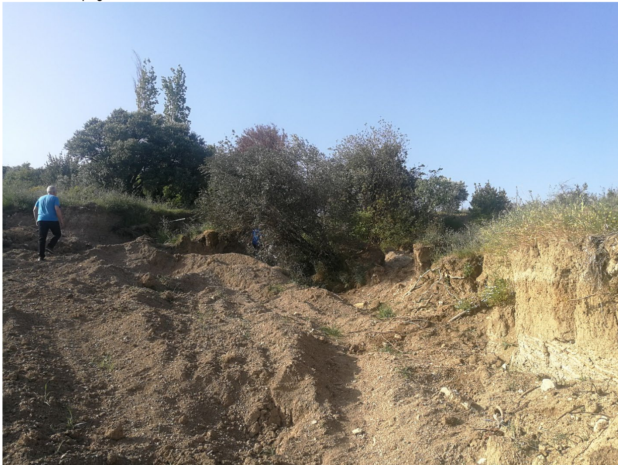
266 – прекъснатата тръба от импровизиран водопровод
