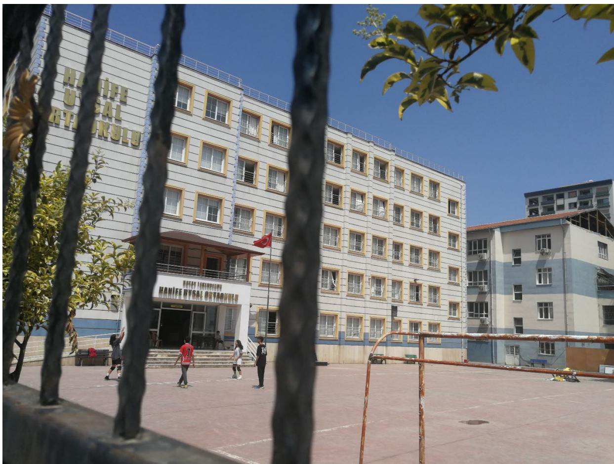
104 – училище със съвременна конструкция – без никакви повреди
