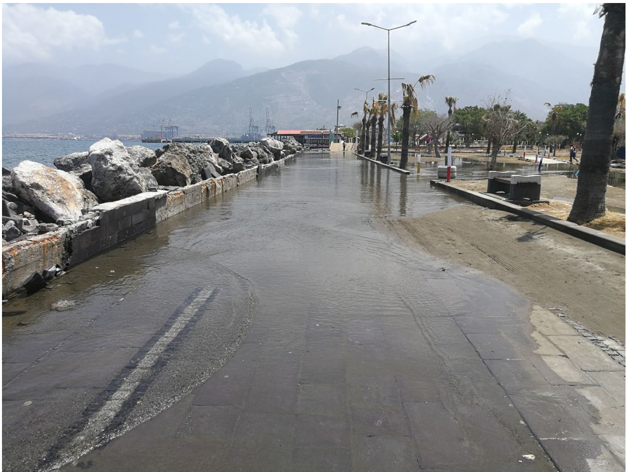
176 - преместване към морето и потъване на изкуствено създадена брегова ивица
