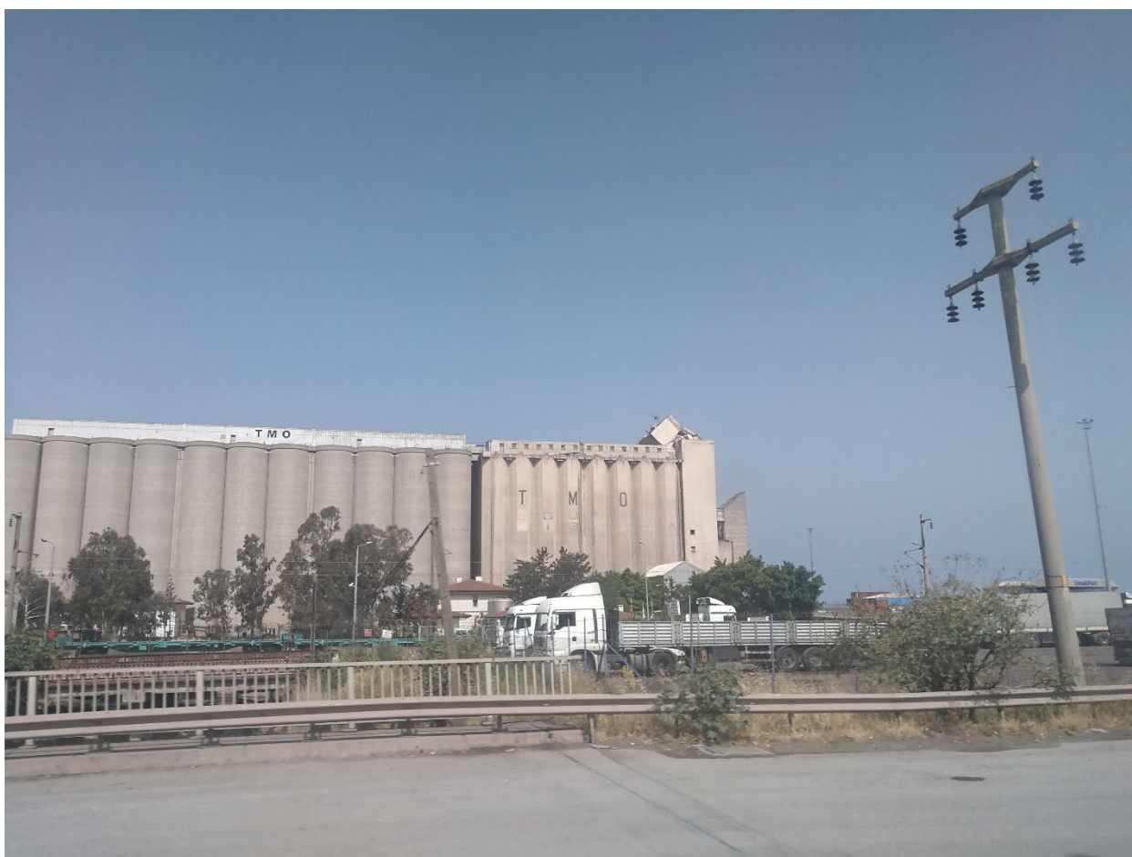
051 –силози със срутена стоманобетонова част на покрива
