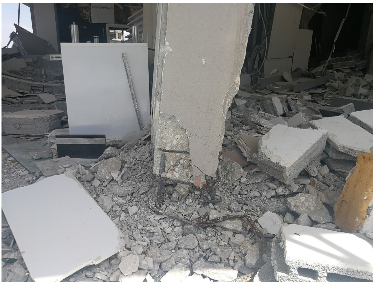
201 – стремената на колоната са със опашки на 90^\circ , вместо на 135^\circ
